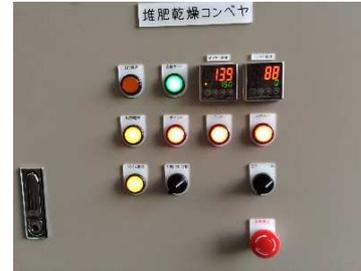
左:ボイラー内温度 右:コンベヤ内温度
